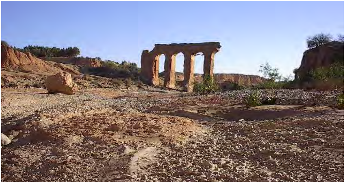
Figure 3. Aqueduc Oued Ouaar (archive M. El Faïz)
