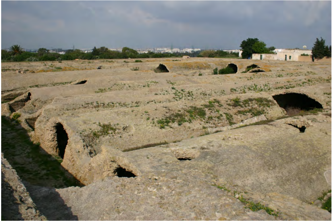
Figure 4. Vue générale des citernes de la Maalga (M. Khanoussi)
