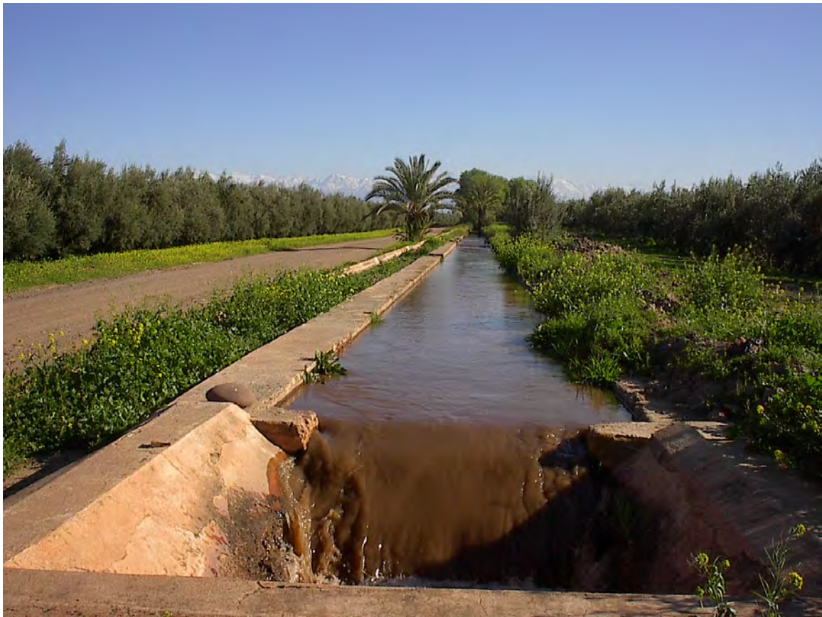
Figure10. Le bassin de décantation des eaux de l'Agdal (archive M. El Faïz)
