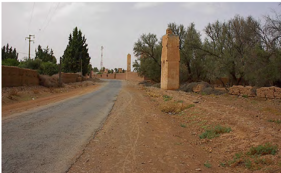
Figure 5. Tours élévatrices de l'eau à Tamesloht (archive M. El Faïz)
