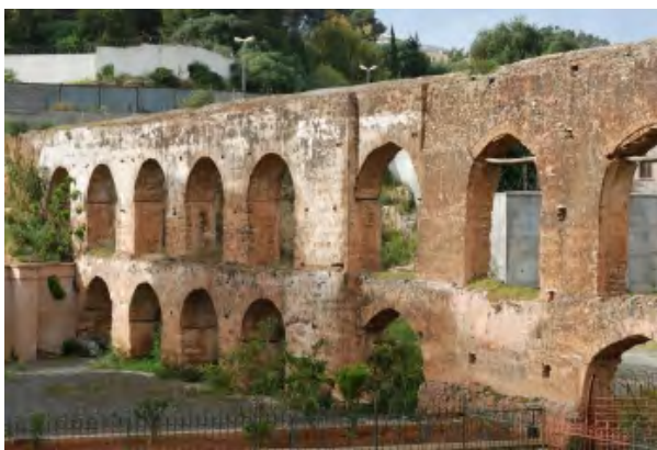
Photo 3. Vestiges de l'aqueduc d'Aïn Zeboudja à Alger (Aghiles, 2009)
