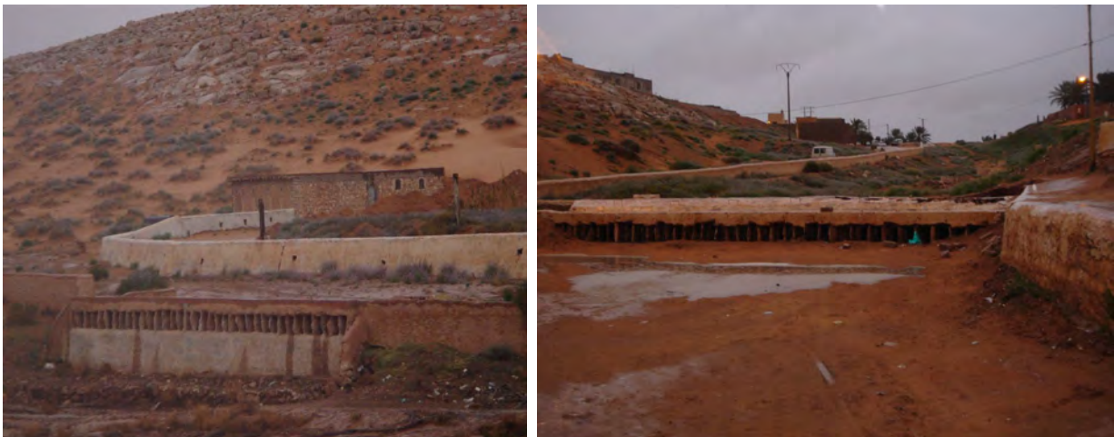
Photos 9a et 9b. Arrivée de l'eau dans l'exutoire canal Bouchemdjen (Y. Djellouli, 2009)
