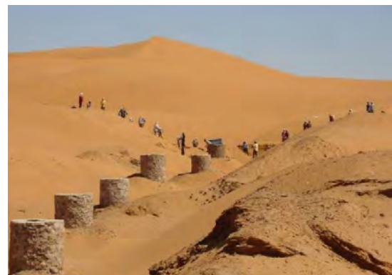
Photo 5.b. Vue au sol des regards d'entretien d'une foggara (Algérie, Terre d'Afrique 2011)
