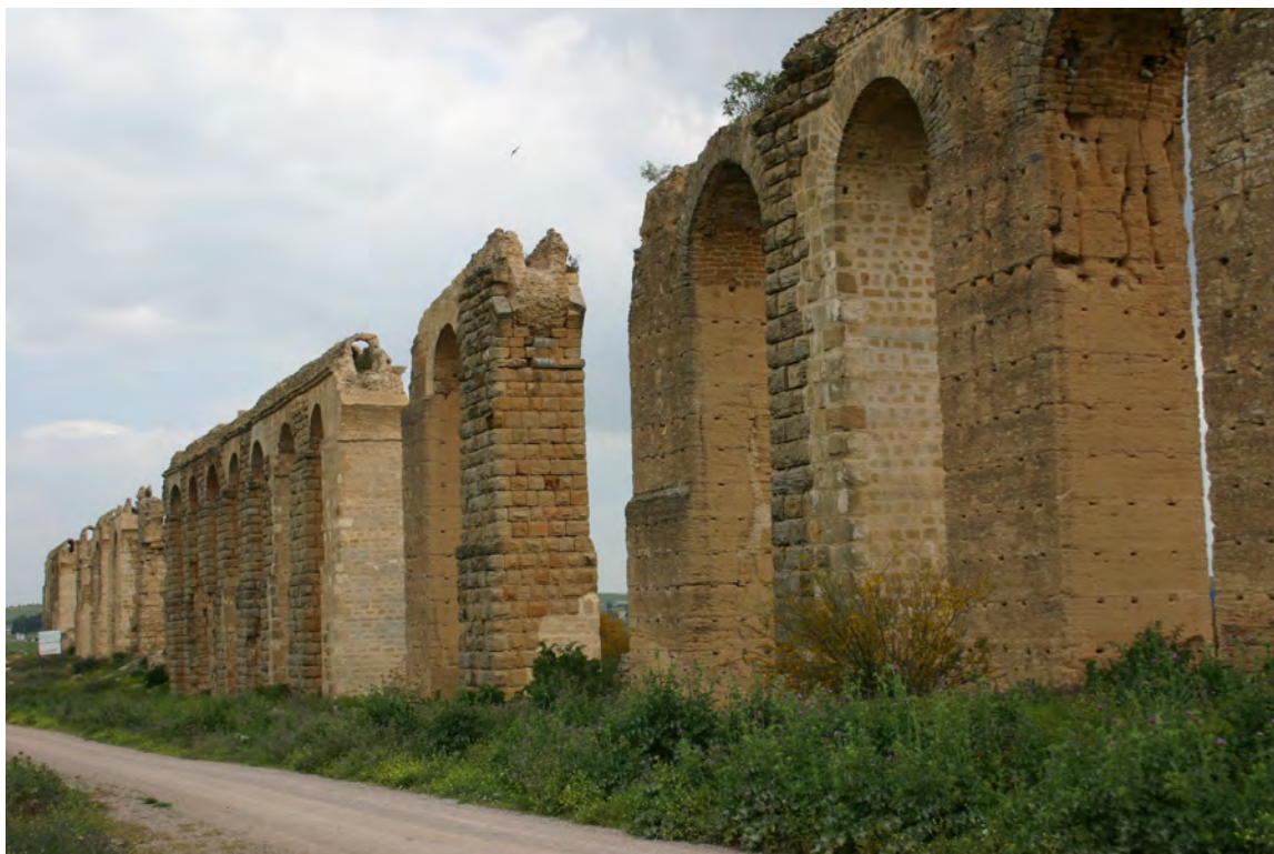
Figure 1. Vue de l'aqueduc de Zaghouan-Carthage (M. Khanoussi)
