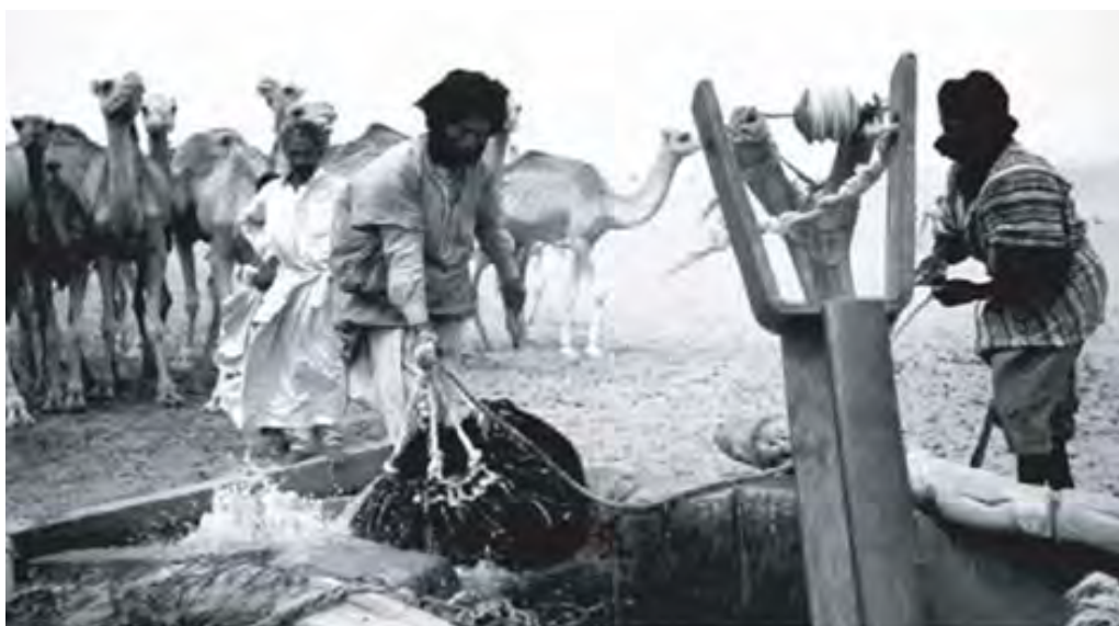
Figure 6. Exhaure de l'eau à bras d'homme à l'aide d'une poulie avec un delou (outre) au puits de Bouir-Ed-déri Parc National du Banc d'Arguin (Sécheresse, 2008, Volume 19, Numéro 4)
