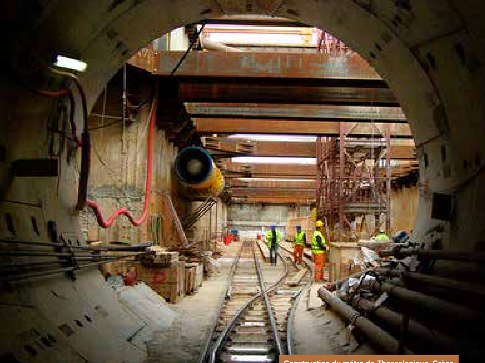
Construction du métro de Thessalonique, Grèce
